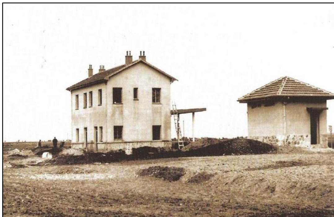
Κατασκευή του σιδηροδρομικού σταθμού Πτολεμαΐδας, αρχές δεκαετίας του 1950.
