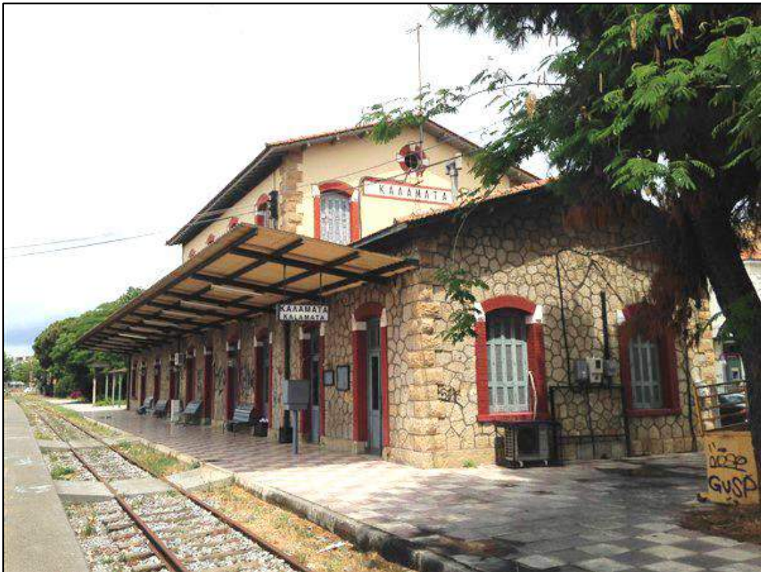
Ο σιδηροδρομικός σταθμός της Καλαμάτας. Η λειτουργία του ανεστάλη το 2011
