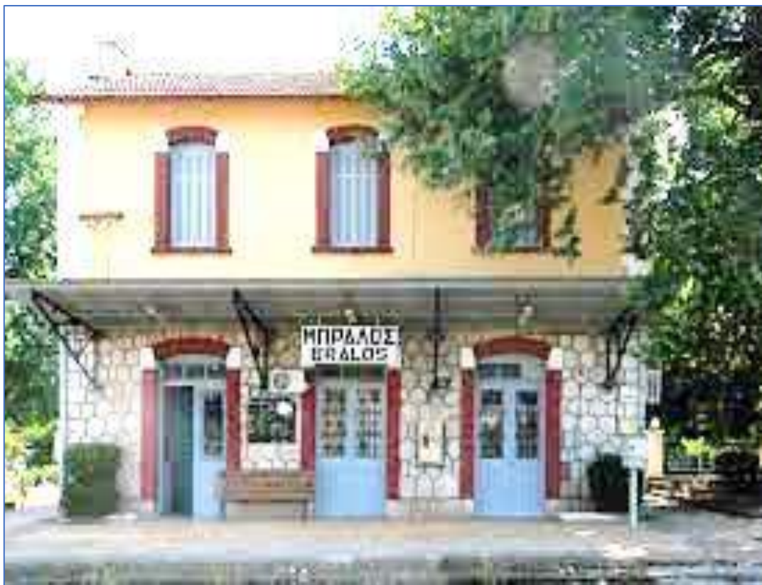
Σιδηροδρομικός σταθμός Μπράλου.
