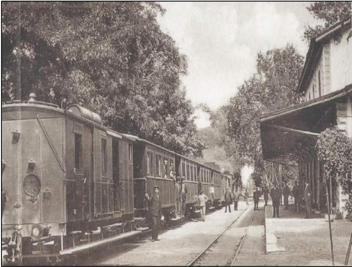
Ο σταθμός των Τρικάλων, στιγμιότυπο από την καθημερινή λειτουργία του.
