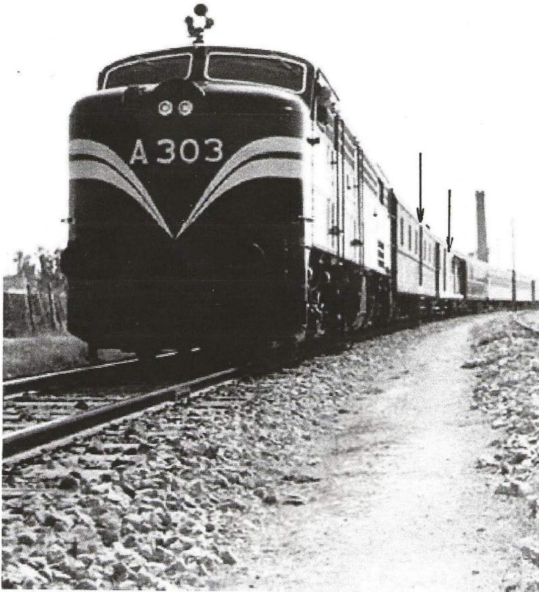
Συρμός των Σ.Ε.Κ. που περιλαμβάνει, αμέσως μετά τη μηχανή, δύο ταχυδρομικά βαγόνια, ιταλικής κατασκευής του 1950, όπως δείχνουν τα βέλη. Το πρώτο, με την πόρτα στο μέσο, είναι το απλό ταχυδρομικό και το άλλο, το μικτό με σκευοφόρο.
