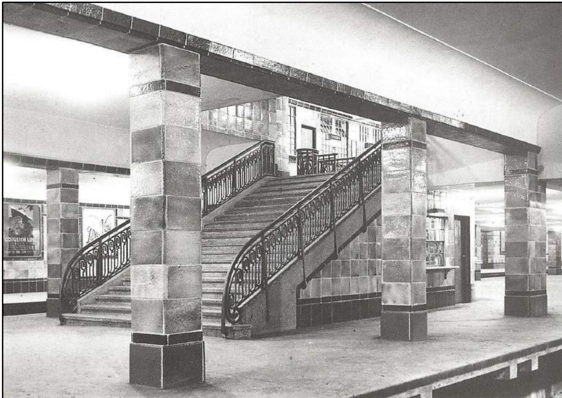
Η κάθοδος προς τον δεύτερο υπόγειο διάδρομο του σταθμού του ηλεκτρικού σιδηροδρόμου κάτω από την πλατεία Ομονοίας, στο διάδρομο όπου διέρχονται οι σιδηροδρομικές γραμμές.
