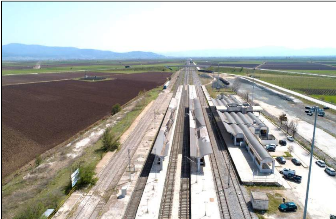
Πανοραμική άποψη του σταθμού Παλαιοφαρσάλου, όπου διακρίνεται η διασταύρωση των δύο γραμμών. Της μίας, μετρικού εύρους, της διαδρομής από Βελεστίνο προς Καλαμπάκα, και της άλλης, διεθνούς εύρους, από Αθήνα προς Λάρισα.
