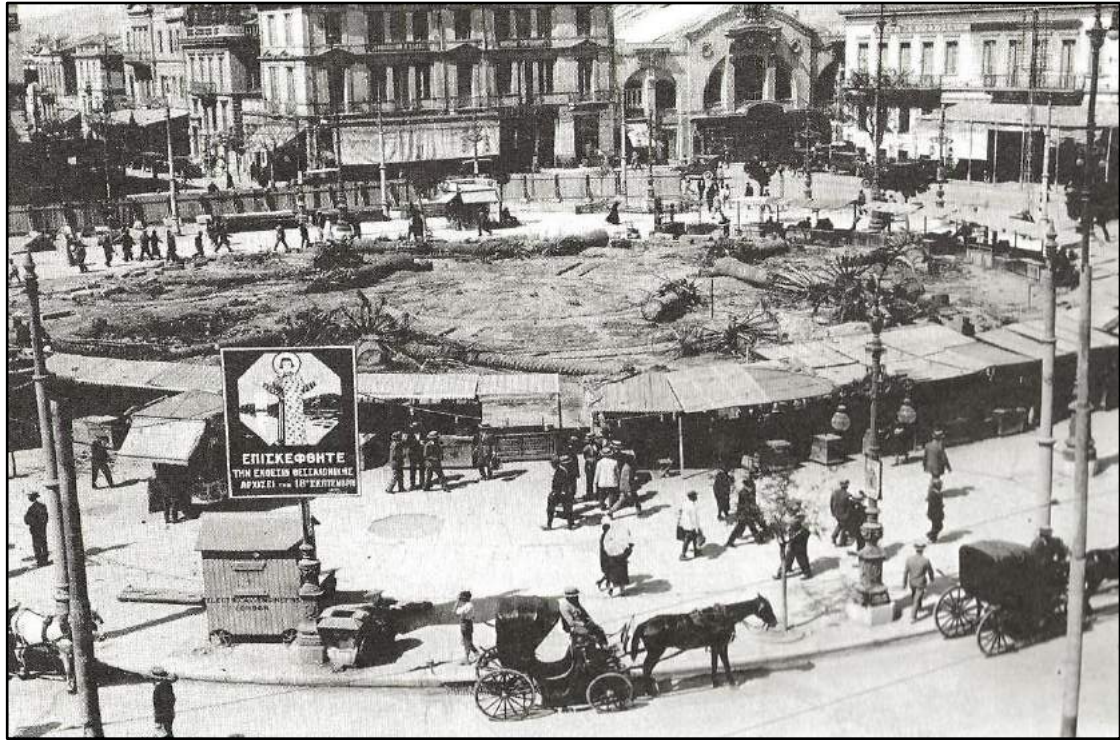
Η πλατεία Ομονοίας κατά την έναρξη των εργασιών εκσκαφής για την κατασκευή του υπόγειου σταθμού του ηλεκτρικού σιδηροδρόμου, τον Σεπτέμβριο του 1927. Απέναντι προς τα δεξιά το ιδιόμορφο κτίριο είναι το θέατρο Κοτοπούλη.
