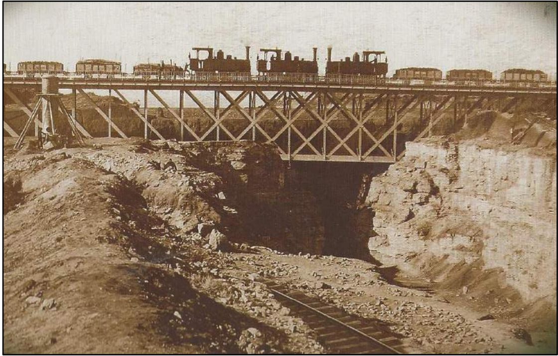
Η σιδηροδρομική γέφυρα του Ισθμού της Κορίνθου είχε αρχίσει να λειτουργεί με μια μικρότερη κατασκευή, πριν από την ολοκλήρωση της διάνοιξης της διώρυγας.
