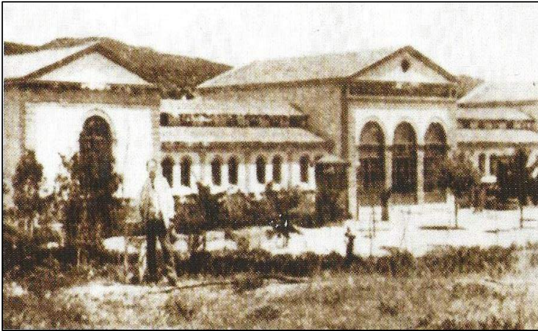
Το κτίριο του θεραπευτικού συγκροτήματος των λουτρών Κυλλήνης που κατασκευάστηκε από τους Σ.Π.Α.Π. και λειτούργησε στα 1892.
