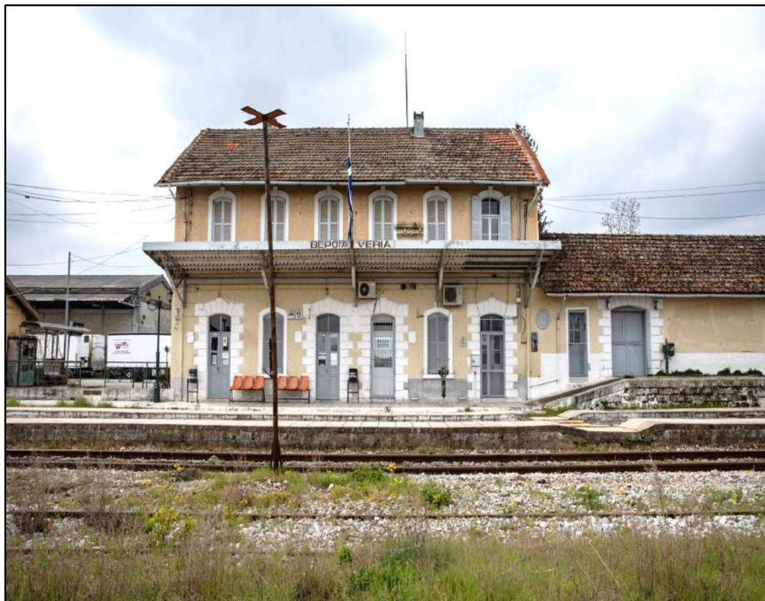
Σιδηροδρομικός σταθμός Βέροιας Διαδρομή από Αμύνταιο μέχρι Κοζάνη.
