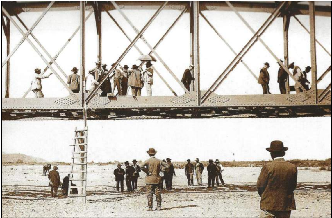
Επιθεώρηση των ζευκτών της γέφυρας του Αλφειού κατά την παραλαβή της, το 1902.
