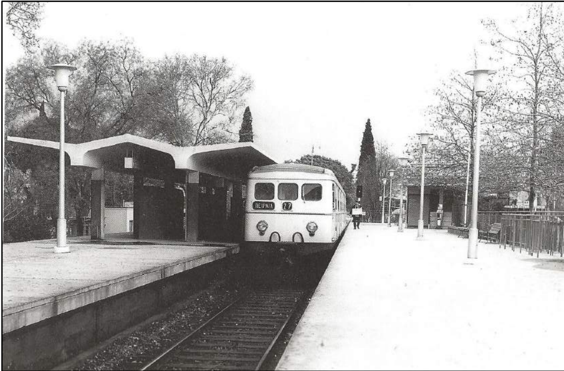
Ο τερματικός σταθμός του ηλεκτρικού σιδηροδρόμου στην Κηφισιά, που λειτούργησε το 1957, κατά την παραλαβή νέου τύπου αμαξοστοιχίας.
