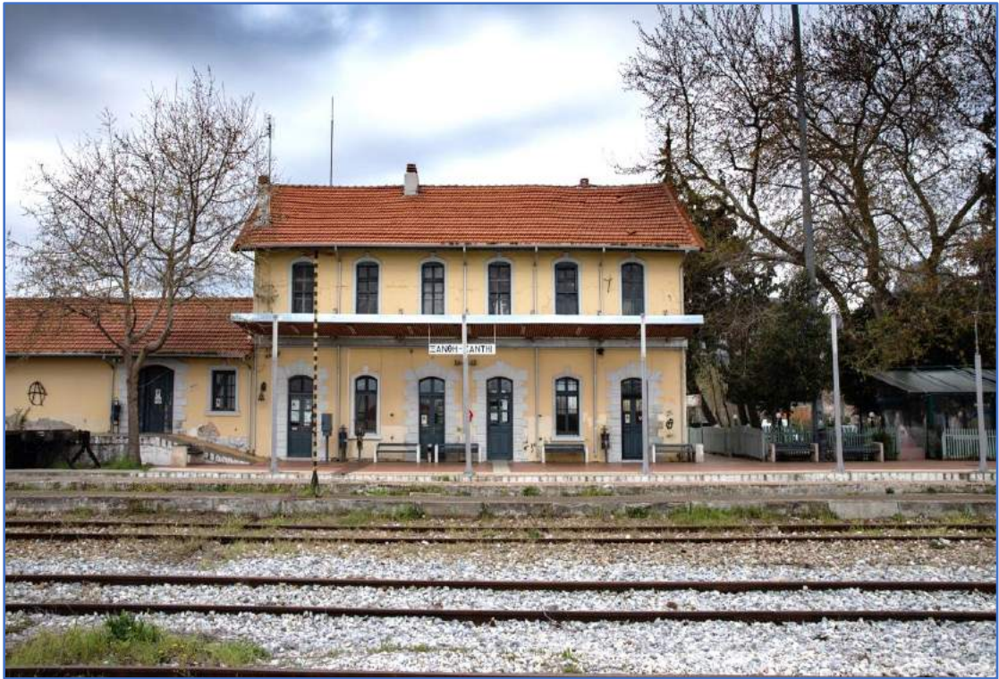
Σιδηροδρομικός σταθμός Ξάνθης.
