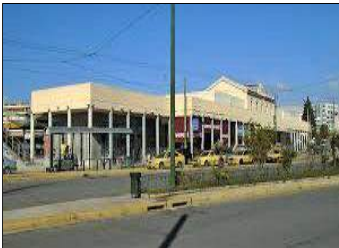
Το κτίριο του σταθμού των Σ.Ε.Κ. στην Αθήνα, μετά από νέες, μεταγενέστερες βελτιώσεις.
