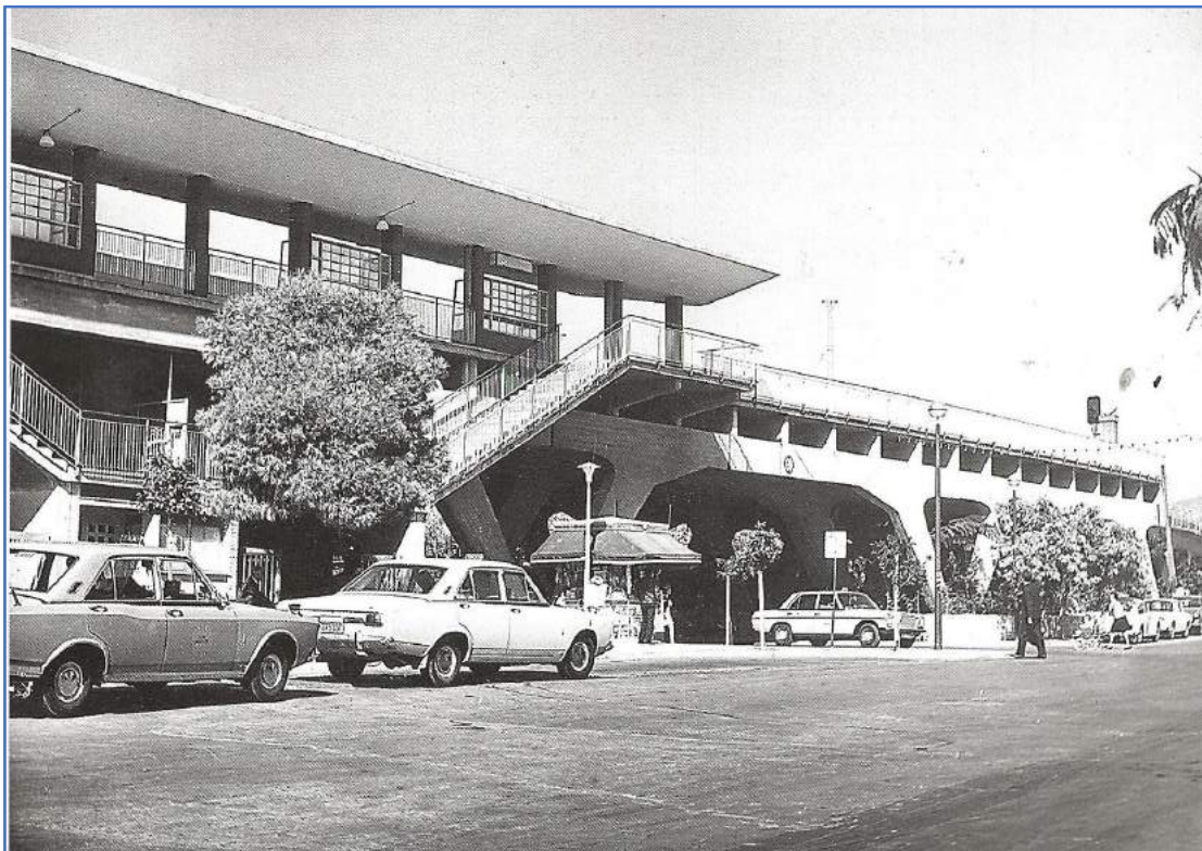
Η υπερυψωμένη κατασκευή του σταθμού του ηλεκτρικού σιδηροδρόμου στο Μαρούσι. Λειτουργήσε το 1956.
