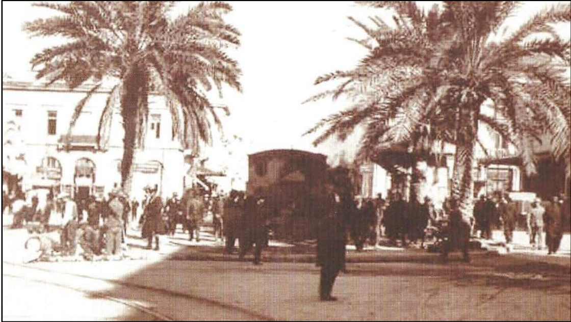
Ο αρχικός σταθμός των ατμοκίνητων σιδηροδρόμων Αττικής, στην πλατεία Λαυρίου, στην Αθήνα, δίπλα στην πλατεία Ομονοίας. Ο σταθμός αυτός ήταν υπαίθριος, χωρίς το κλασικό σιδηροδρομικό κτίριο. (Δεκαετία του 1920).
