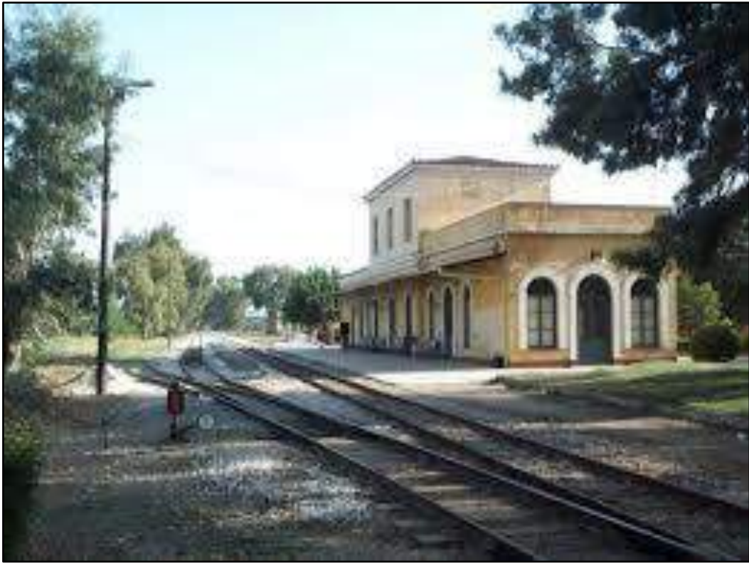
Ο σιδηροδρομικός σταθμός Άργους, ο οποίος κατασκευάστηκε και πρωτολειτούργησε το 1886, και εξακολουθεί να λειτουργεί απρόσκοπτα μέχρι τις αρχές του 21 ου αιώνα.
