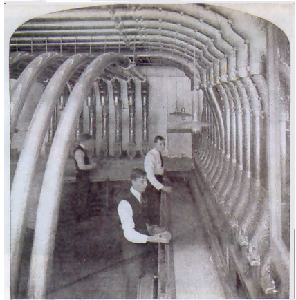
Αριστερά: Κεντρικό πνευματικό ταμείο μεγάλης εταιρείας της Βοστώνης (είσπραξη χρημάτων μέσω πνευματικών σωλήνων). Δεξιά: Κέντρικός σταθμός πνευματικού ταχυδρομείου του Σικάγου.
