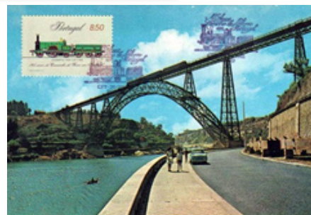
2 Η σιδηροδρομική γέφυρα Μαρία Πια.
