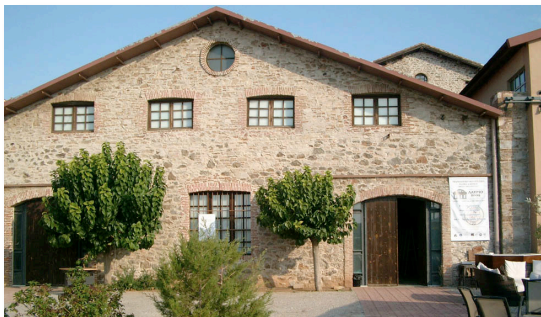
Το κτήριο του “Μηχανουργείου Ι” που φιλοξένησε την έκθεση “ΛΑΥΡΙΟ 2009”
